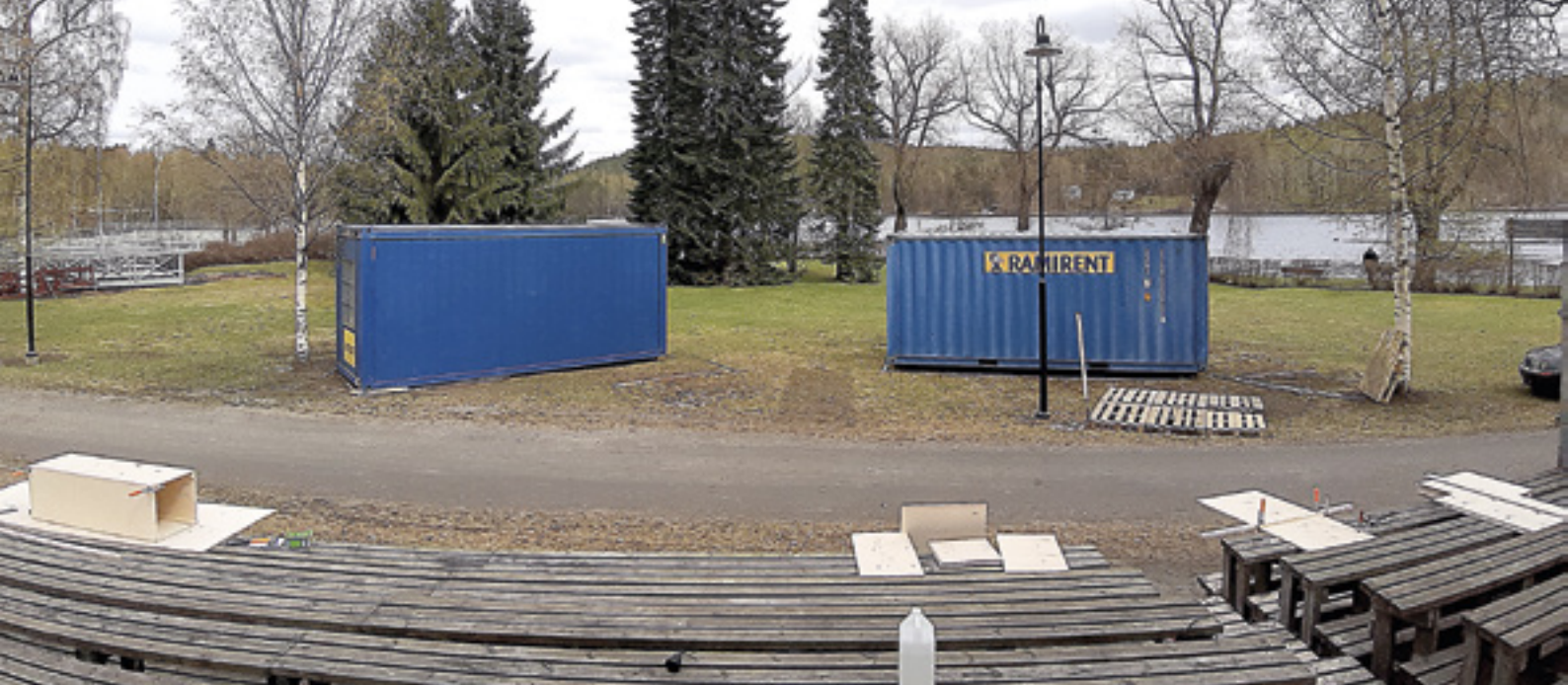
Lavastamisen rakentaminen aluillaan
