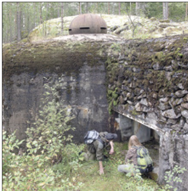
Salpalinjalla voit tutustua jyhkeisiin teräsbetonikorsuihin. Kuvassa kenttätykin ampuma-aukko ja korsun katolla oleva tähytyskupu. Kuvaaja Mika Honkalinna
